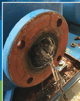
*Les lingettes se prennent dans les pompes et l'équipement. Ainsi, l'opérateur doit toujours être à l'affût et procéder à de l'entretien.*
