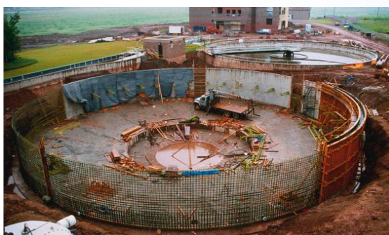
Clarificateur en cours de construction.
