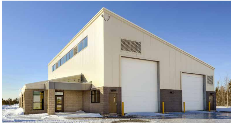
Nouveau centre d'exploitation des activités de compostage avec garage à Moncton.
